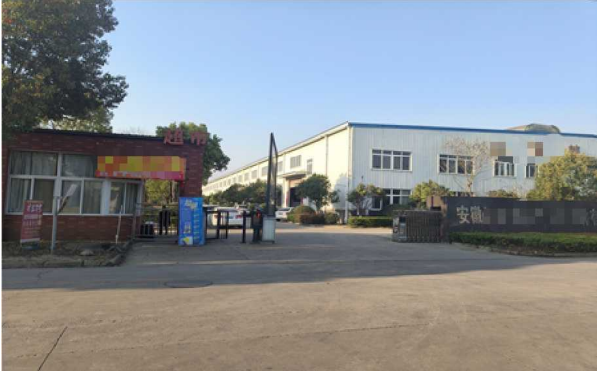
Factory entrance 厂房入口
